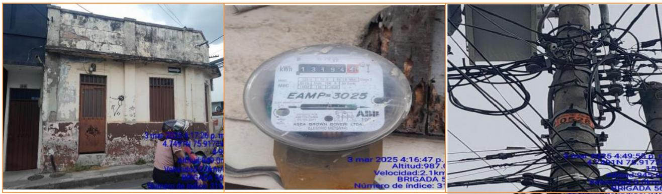
Se encuentra predio deshabitado con medidor monofásico 2413025 clase 2 del año 1994 sin caja ni pin de corte, a una altura de 2.40 metros de altura y con acometida aérea grafilada. **Se informa que, para poder reactivar la matrícula, el usuario debe normalizar la medida completamente, ya que el medidor actual se encuentra obsoleto, por lo que se requiere cambiar por un medidor electrónico clase 1 para garantizar la correcta facturación de los consumos registrados.**
