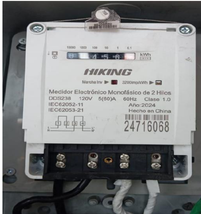
Foto No 1. Medidor No. 24716068 encontrado en terreno instalado y energizado sin encontrarse registrado en el sistema comercial de la compañía con una lectura acumulada de 456 kWh.
