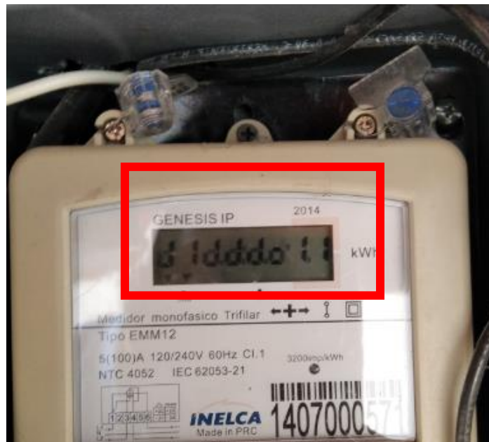
Foto No 5. Irregularidad hallada en el momento de la visita.
