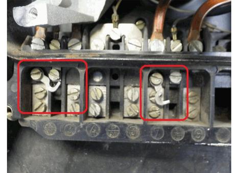
BLOQUE DE TERMINALES FUERA DE POSICIÓN (Laminas del punte de tensión desplazadas de las fases R y S )
