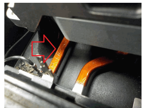
CIRCUITO DE CORRIENTE DETERIORADO (Aislamiento del arrollamiento)
