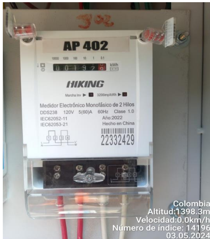
Foto No 6. Medidor No. 22332429 encontrado en terreno instalado y energizado sin encontrarse registrado en el sistema comercial de la compañía con una lectura acumulada de 193 kWh, de los cuales ya se han cobrado 59.9 kWh (acta 3014853871 del 19 de diciembre de 2023) y se encuentran pendientes por cobrar 133.1 kWh.
